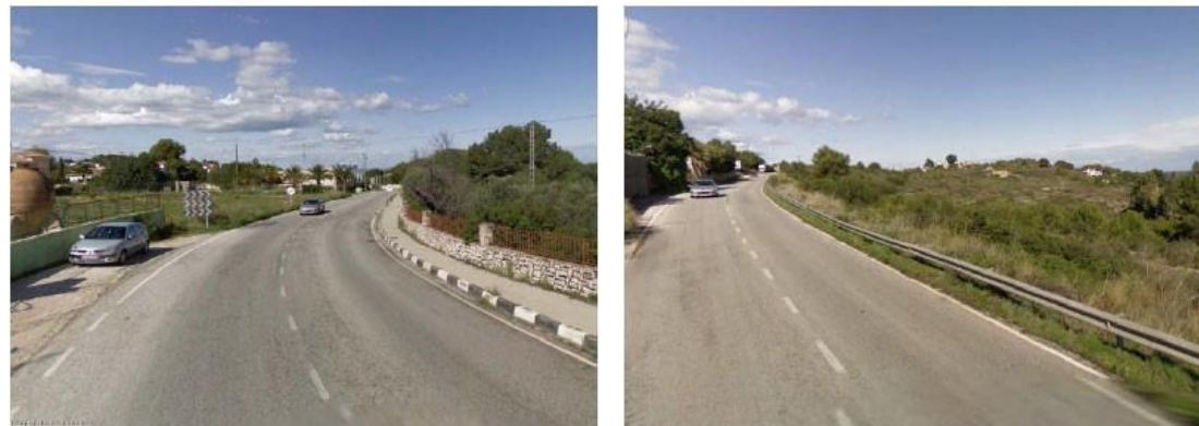
Imágenes de la carretera CV-736 , que se declarará como paisajística con el nuevo PGOU.
